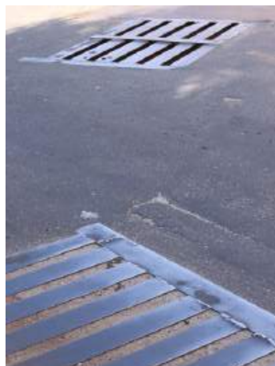
Ampliação do gradil de captação da água da chuva, na Rua São Pedro da Aldeia, bairro Olhos D'Água
