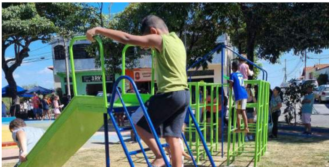
Instalação de brinquedos na Praça José Sobrinho Barros
