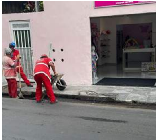
Implantação de canaletas para escoamento da água da chuva, na Av. Padre José Maurício, Vista Alegre
