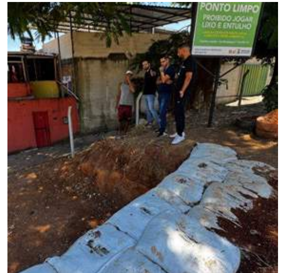
Avaliação das obras de contenção no Castanheira
